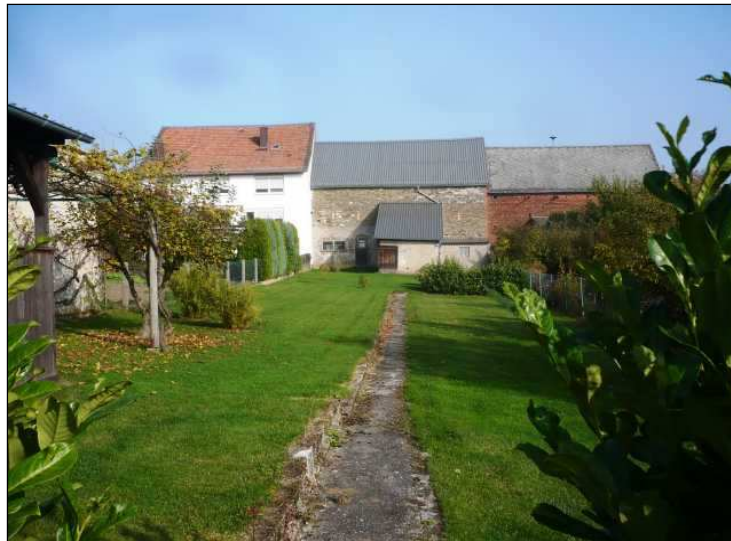
Abbildung 19: Scheunenkrantzstruktur – Ortslage Mudershausen
